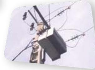
Pour utiliser l'électricité, il suffit de diminuer la tension circulant dans les lignes électriques. **Un transformateur abaisseur de tension est utilisé.**
